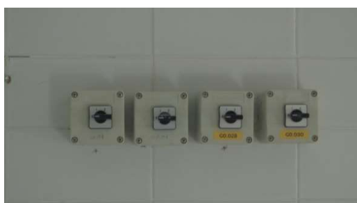
Figura 11 – Interruptor para sistema de Ventilação e filtros HEPA
